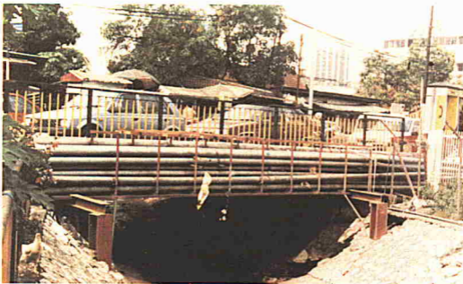
GAMBAR 35 Jambatan yang dibina menggantikan jambatan sempit (jambatan gesel). Foto 1995.
