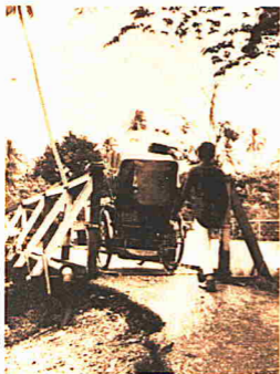
GAMBAR 33 Jambatan sempit yang merentas sungai Bonus di Jalan Perkin (Jalan Raja Abdullah) Kg. Bharu, jambatan ini sangat terkenal pada masa pasar minggu di Jalan Perkin dengan nama jolokan jambatan gesel. Foto 1955.
